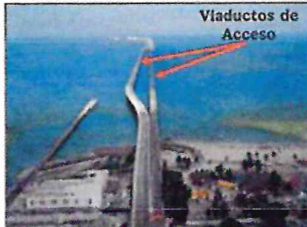
Viaductos de acceso al recinto portuario.
